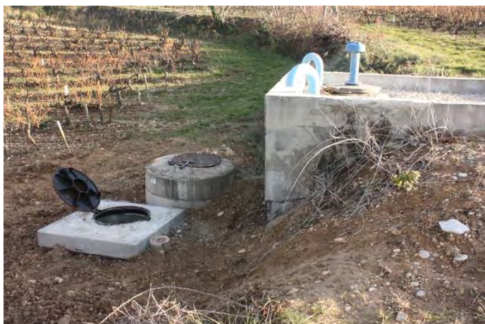
Ouvrage d'Hautimagne Vue extérieur
